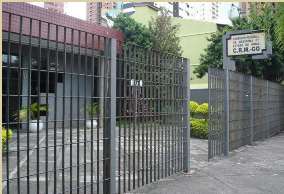
Sede Cremego antes da ampliação.
