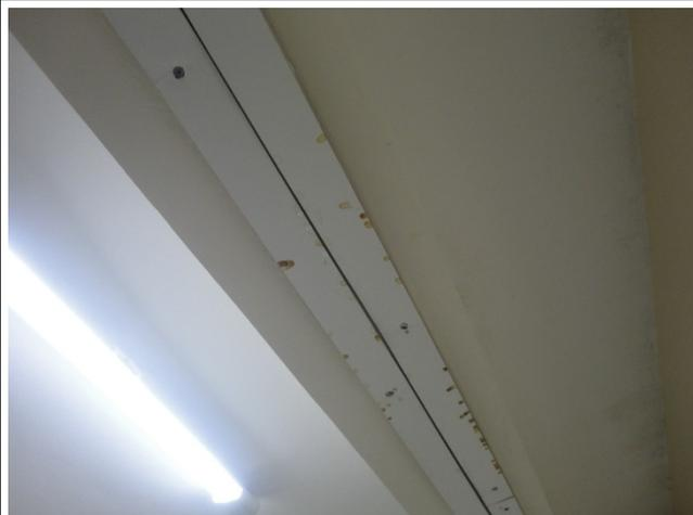
*Visão do teto de um dos consultórios da emergência com infiltrações e mofo*
