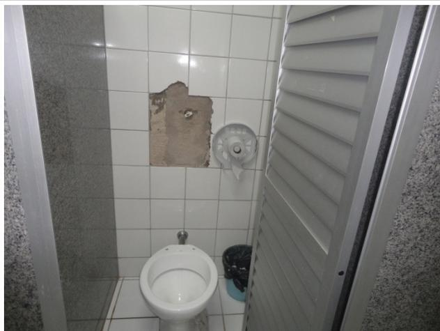
*Visão do box do banheiro com bacia sanitária. Falta lixeira com tampa acionada por pedal e revestimento na parede*
