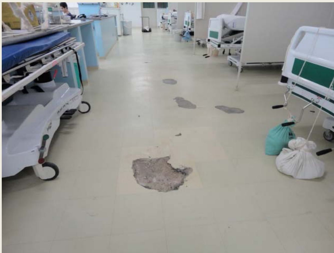
Buraco no piso da UTI 2
