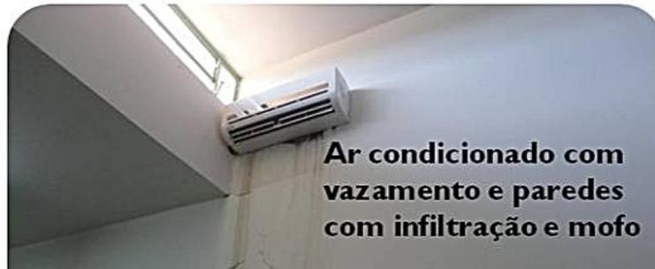
**Ar condicionado com vazamento e paredes com infiltração e mofo**
