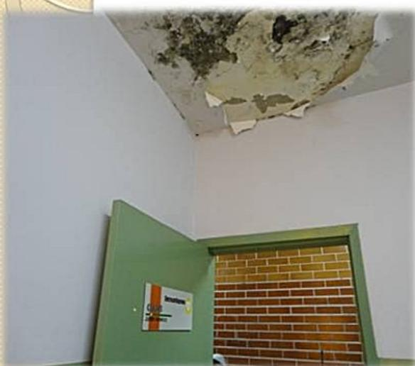
**Grande infiltração no teto da sala de ECG**
