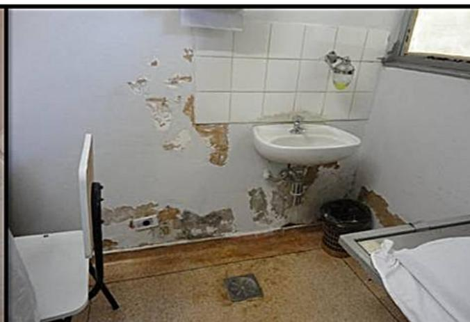
**Paredes com mofo e infiltrações e lixeira sem tampa com acionamento por pedal**
