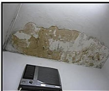
**Visão do teto do consultório com áreas sem pintura e com infiltrações**
